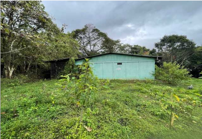
Descripción: ASPECTOS DEL LOTE. LADO NORTE DE LA CONSTRUCCIÓN
