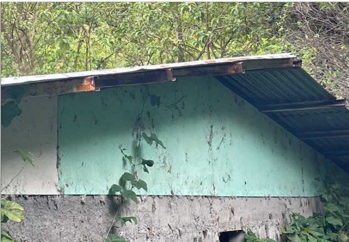
Descripción: ESTADO DE LAS CONSTRUCCIONES. ESTADO DE LA ESTRUCTURA DE TECHO
