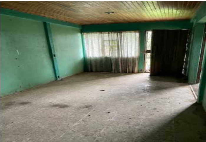
Descripción: ASPECTO DE LAS CONSTRUCCIONES. SALA
