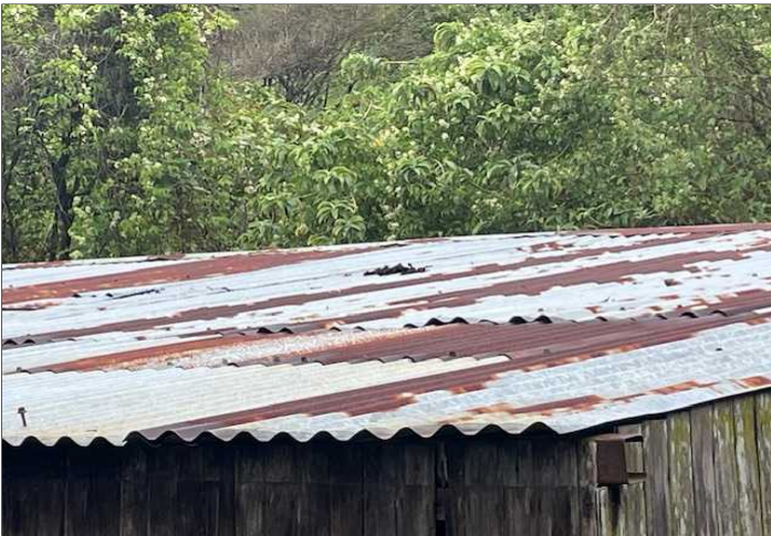
Descripción: ESTADO DE LAS CONSTRUCCIONES. ESTADO DE LA CUBIERTA
