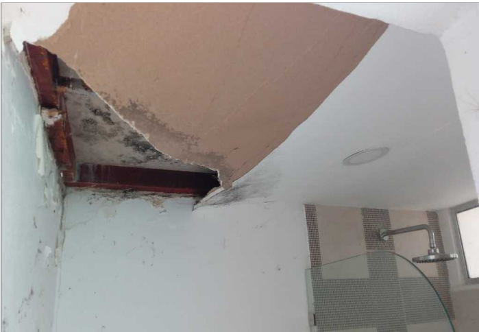
Descripción: Cielo a reparar en baño de primer planta
