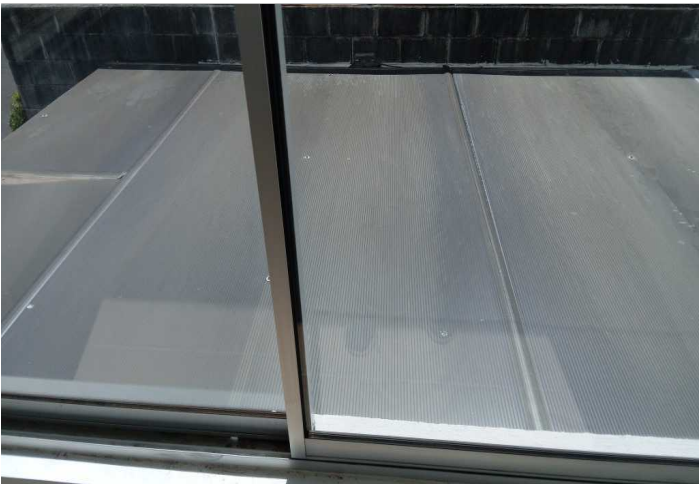
Descripción: Vista de techo policarbonato en patio
