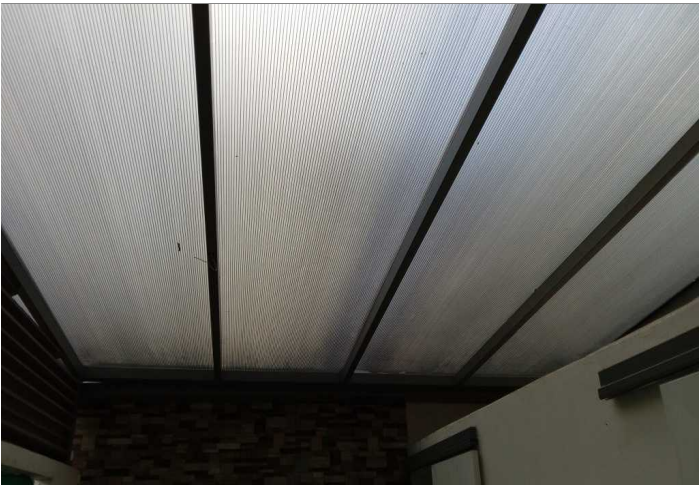
Descripción: Techo de Patio lamina policarbonato
