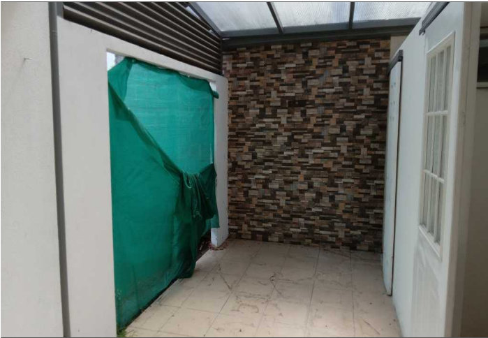
Descripción: Patio posterior techado
