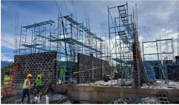
Placa de fundación y paredes de primer nivel
