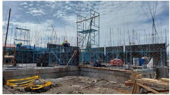
Placa de fundación y paredes primer nivel
