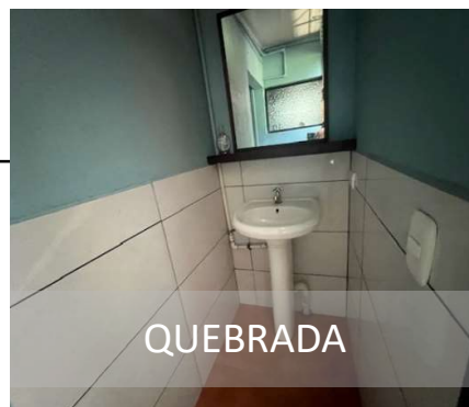
VISTA LA CONSTRUCCION
