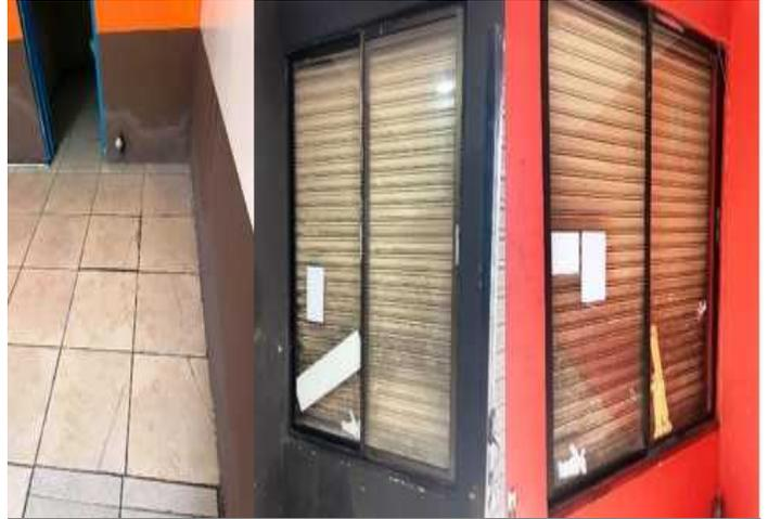
Descripción: Daño de piso en primer local/ Acercamiento de ventanas con reventadura por el lado interno del
