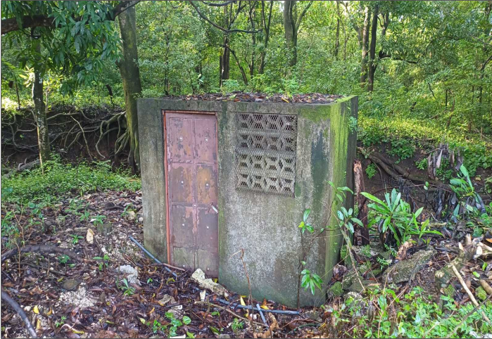
Descripción: BODEGA Y POZO DE AGUA
