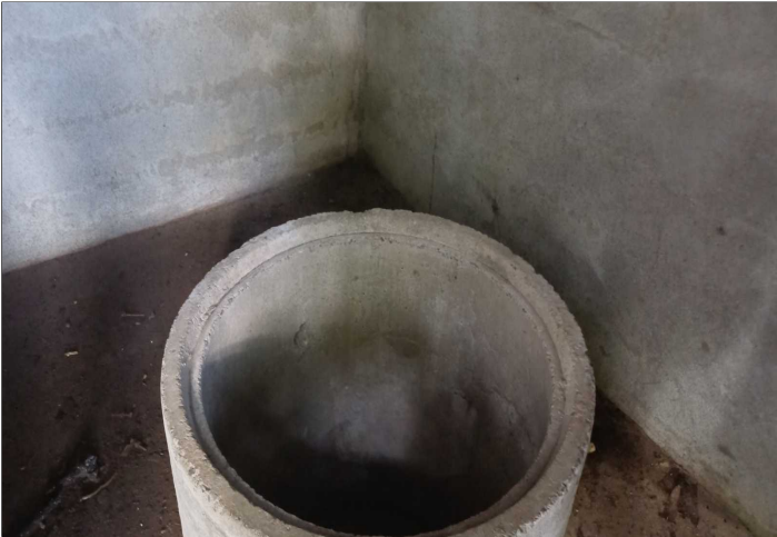
Descripción: INTERIOR DE POZO
