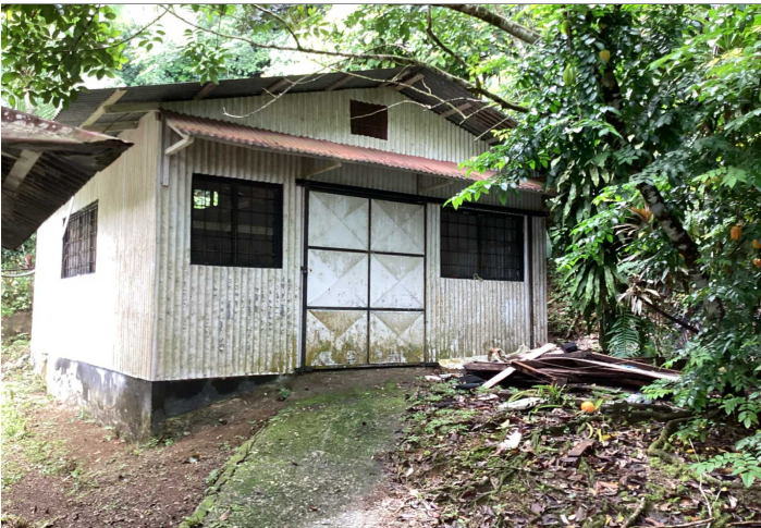
Descripción: FACHADA DE LA BODEGA
