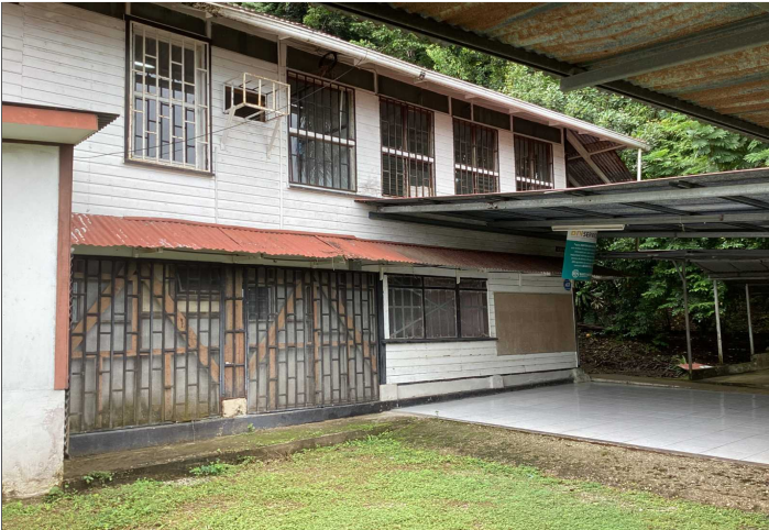
Descripción: FACHADA PRINCIPAL
