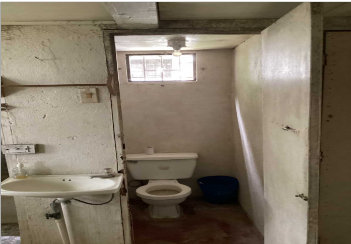
Descripción: SERVICIO SANITARIO EN PLANTA BAJA
