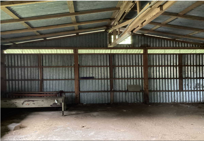
Descripción: BODEGA A UN COSTADO DERECHO DE LA VIVIENDA
