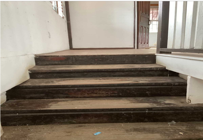
Descripción: ESCALERAS DE ACCESO A SEGUNDO NIVEL
