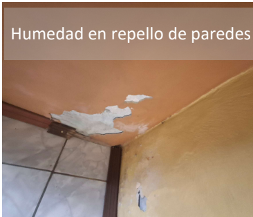
Humedad en repello de paredes
