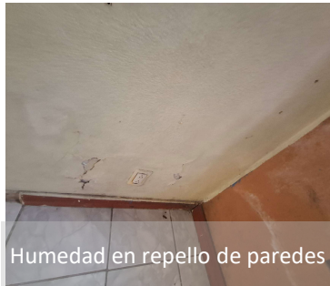
Humedad en repello de paredes
